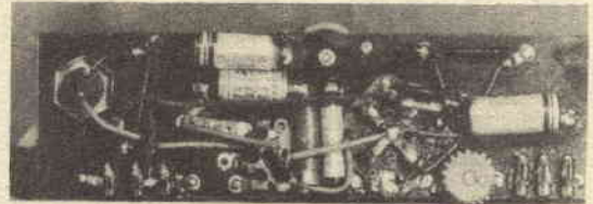
FIG. 5 bis - Foto del montaggio del telaio - parte inf.
